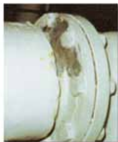
フランジの補修
